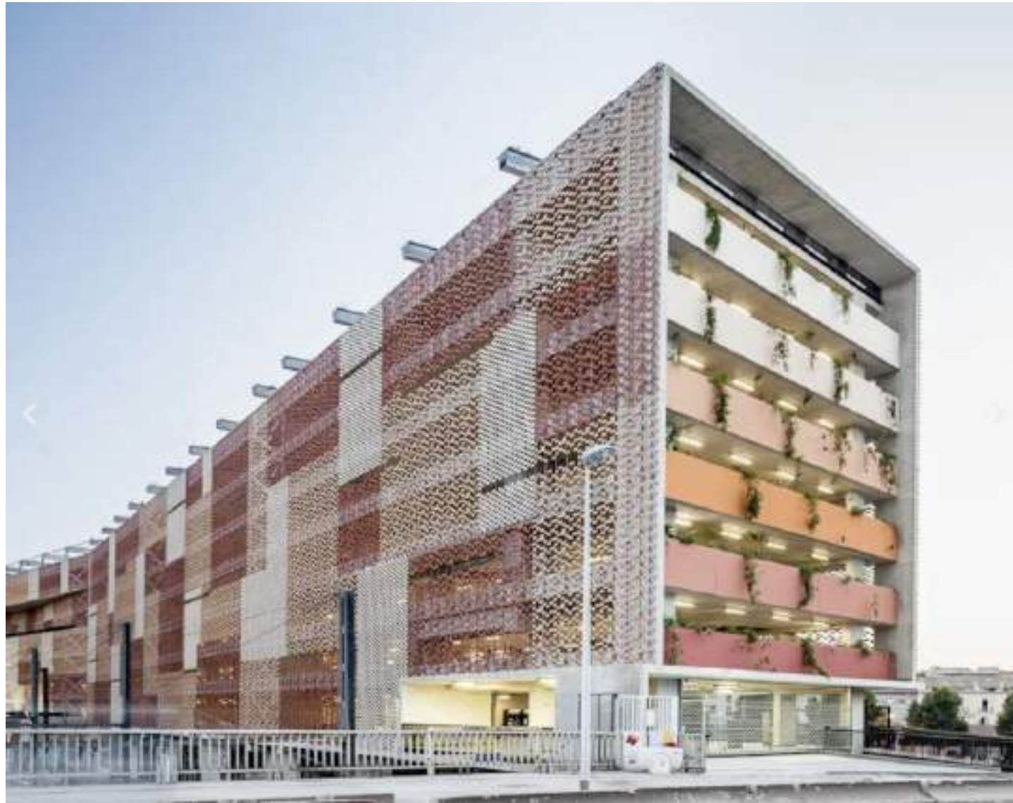
APARCAMIENTO SAINT ROCH-MONTPELLIER. Archikubik Studio
